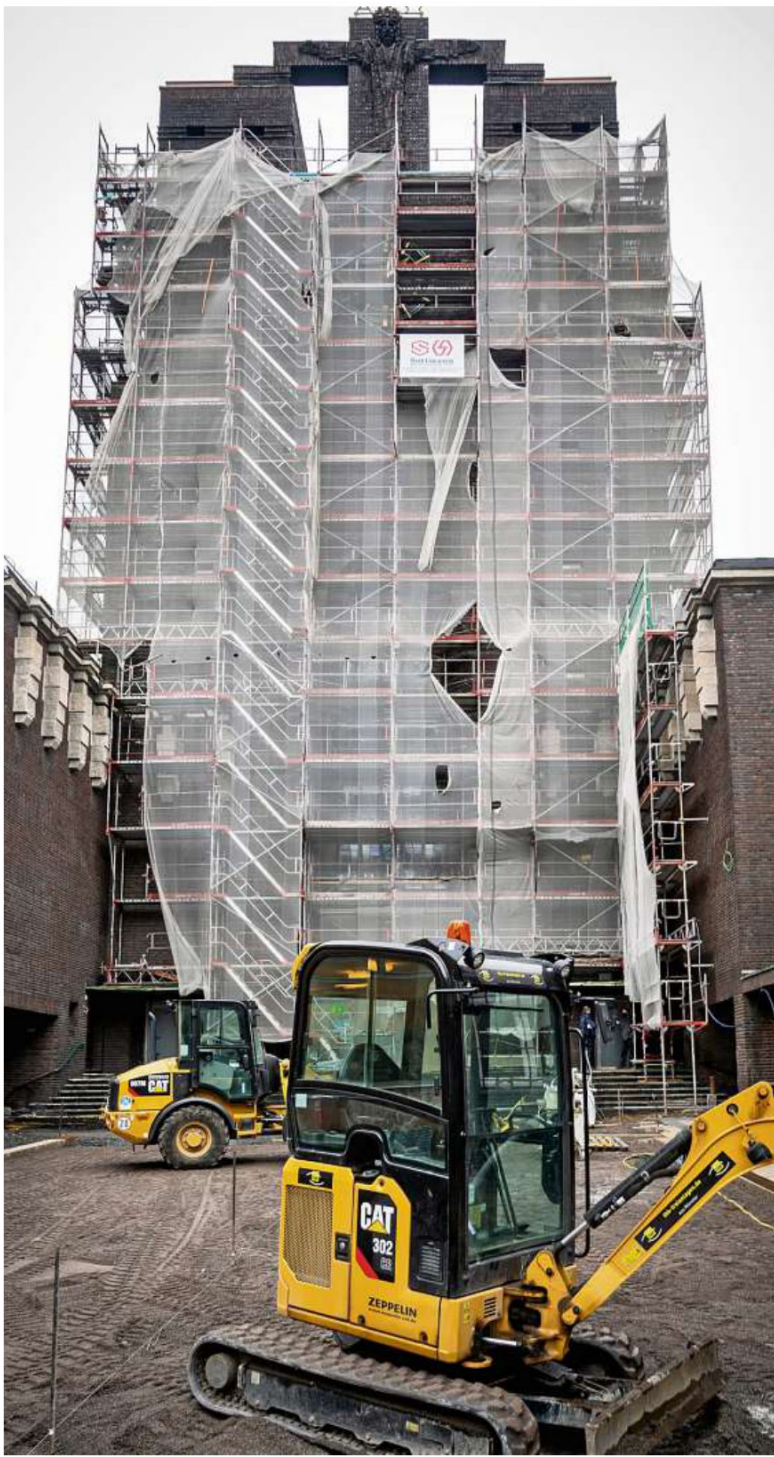
Der Turm der Heilig-Kreuz-Kirche ist weiterhin eingerüstet, weil dort zusätzliche Arbeiten angefallen sind. FOTOS: INGO OTTO / FUNKE FOTO SERVICES
