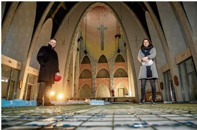
Helmut Hasenkox und Architektin Kerstin Gäfke begutachten auch die Fußbodenheizung, die derzeit installiert wird.
