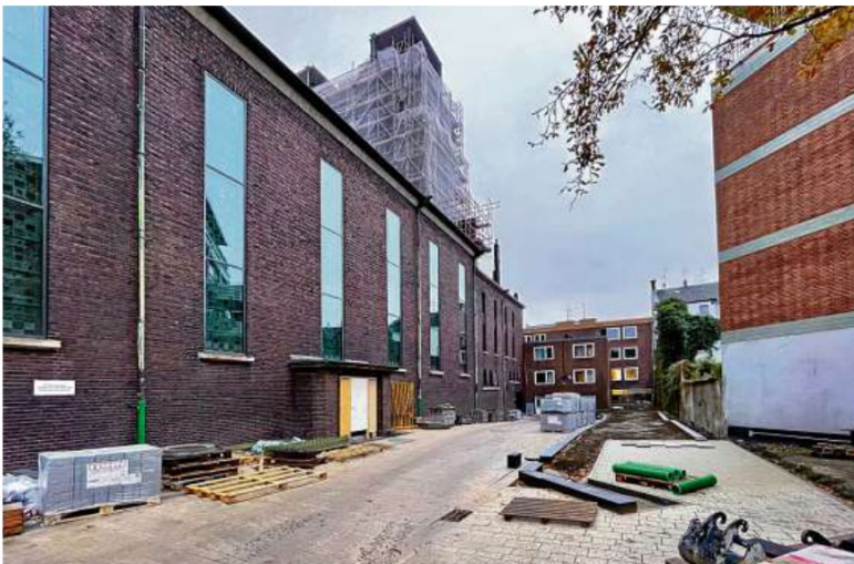
Rund um die Heilig-Kreuz-Kirche in Ückendorf wird derzeit auch schon das neue Pflaster verlegt.
